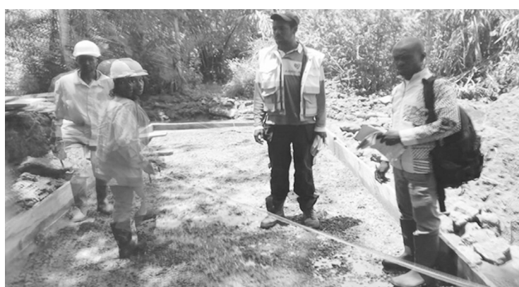
Travaux de construction d'un dalot double de 1 x 1x7m et 1x1x7m à Baziezie avec aménagement des voies d'accès de 500m de part et d'autre exécuté par MAF Construction
