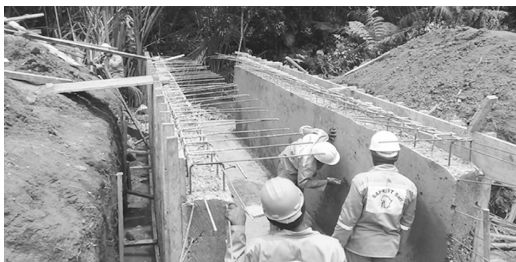
Travaux de construction d'un dalot simple de 1.5 x 1.5 x 7m avec aménagement des voies d'accès de 500m de part et d'autre sur la rivière Saabi à Lagweu, exécuté par Saprest Sarl
