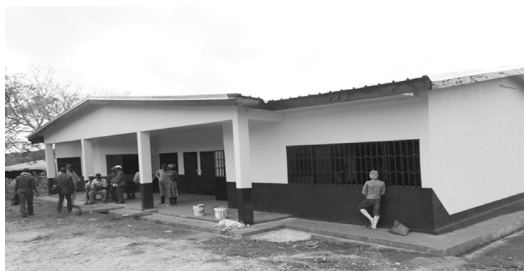
Construction d'un bloc maternel équipé à Tchi Tchi, dans la commune de Bangou
