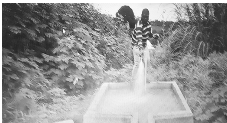
Réalisation d'une adduction d'eau potable à Balougou.
