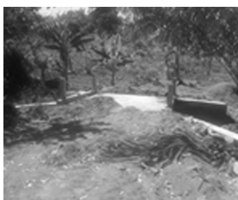
Ponceau de Nkouofè Sud
