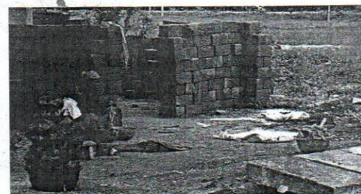
Les riverains ne souffrent plus des inondations.
