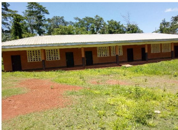
Photo 17 : vue de face du bâtiment en dur de l'EPP de Mbalengue
