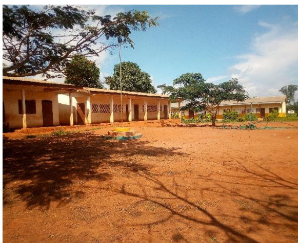
Photo 15 : vue des bâtiments en dur l'EPP de Doumaintang
