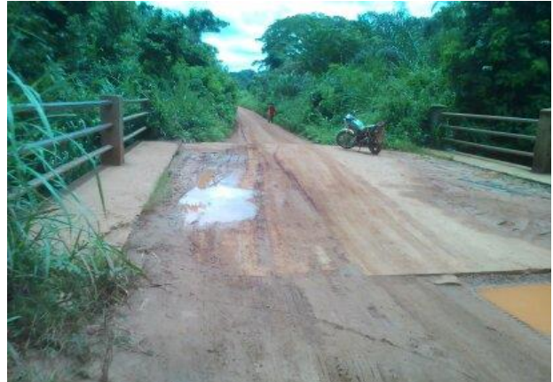
Photo 30 : Pont à la traversé du cours d'eau de Ngomdouma
