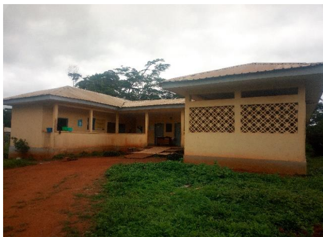
Photo 21 : Vue des bâtiments en dur du CMA de Doumaintang
