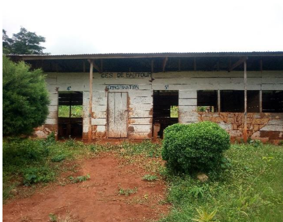
Photo 20 : vue d'un bloc des salles de classe en planche au CES de Baditoum
