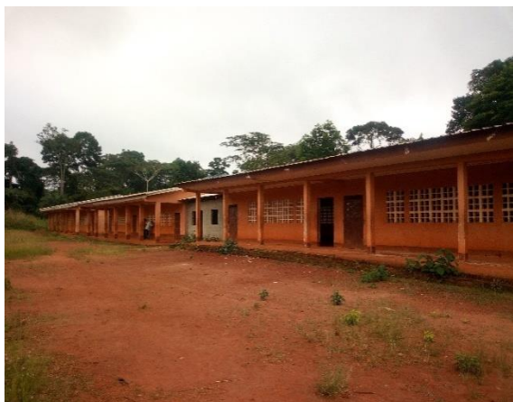
Photo 19 : vue des blocs de salle de classe en dur du lycée de Doumaintang
