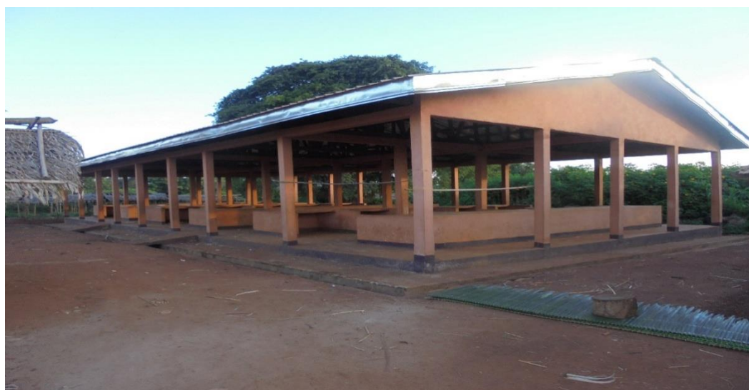
Photo 11 : Hangar de marché MBOUNOU
