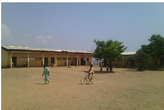
Photo 23. Ecole Publique Mayo Dankali Le bâtiment à gauche de l'image doit être réhabilité au risque de le voir se détériorer Cliché Ndjeuto, 02/2015
