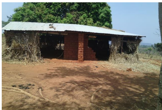
Photo 24. École publique de Tagouri Pont Cliché Ndjeuto, 01/2015
