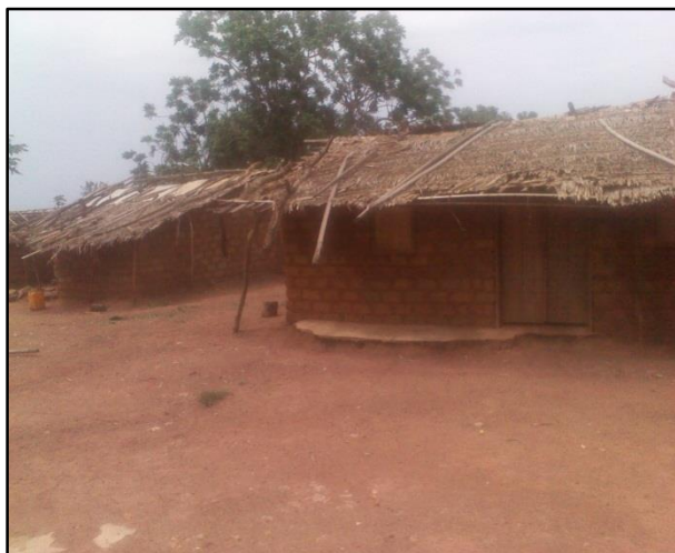
Photo 15 : Habitat traditionnel faite en matériaux provisoires, Avril 2017
