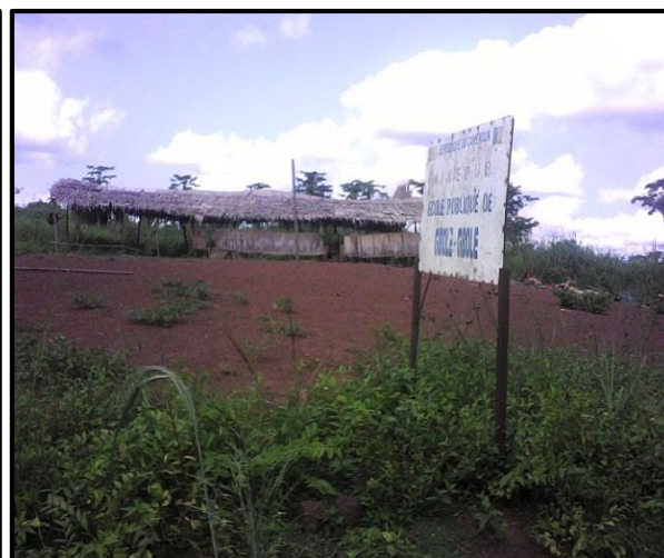
Photo 22 : Salle de classe en matériaux provisoire de l'EPP de GBOLE GBOLE, Juillet 2017
