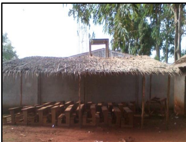
Photo 24 : Salle de classe provisoire de l'EP Bilingue de Kentzou Sinistré de suite d'incendie, Avril 2017.
