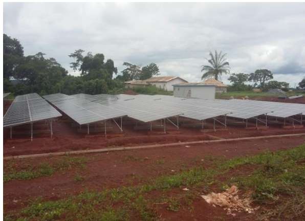
Photo 30 : Vue partielle du champ de plaque solaire communal en construction
