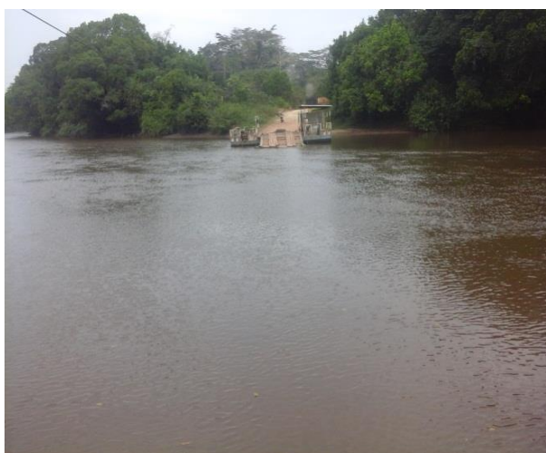
Photo 25 : Bac fonctionnel sur la Doumé
