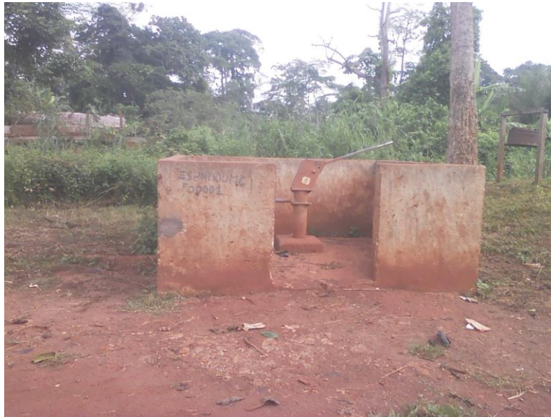
photo 9 : Un point d'eau en panne et quasiment à l'abandon à l'EPP de Mambélé (Photo GIC ALUMNI DE L'EST, 2018)
