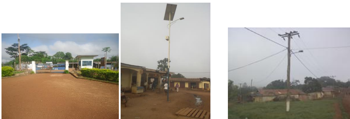
Photo 10 : A gauche la Base ENEO de Moloundou, au milieu une image l'éclairage public solaire et enfin à droite une ligne du réseau électrique ENEO de Moloundou
