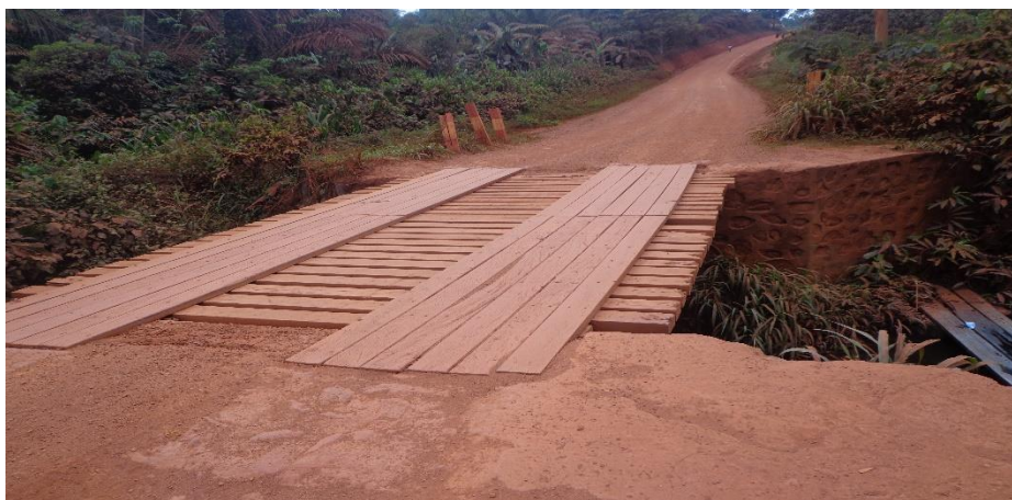
Photo 26: état de route avec pont forestier reliant le village Ampel
