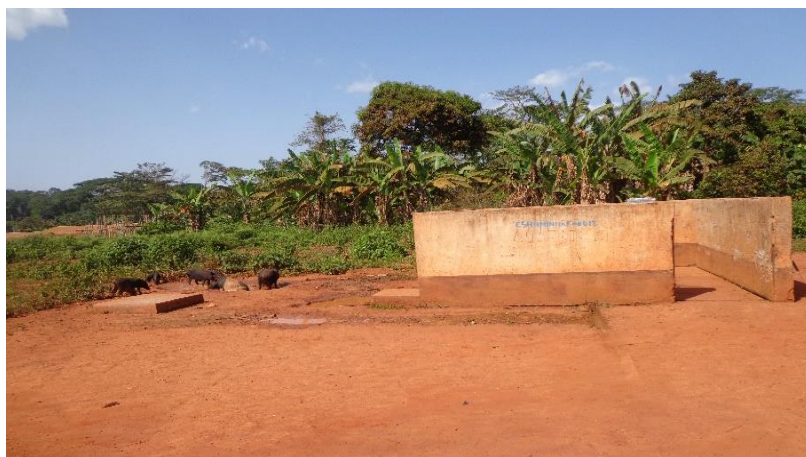
Photo 21: état du puits avec PMH dans le village Malene
