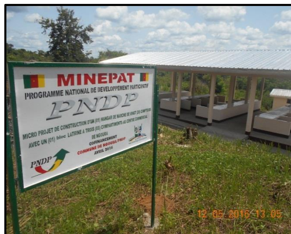
Photo 24 :, Nouveau hangar équipé de comptoirs du centre commercial de Ngoura
