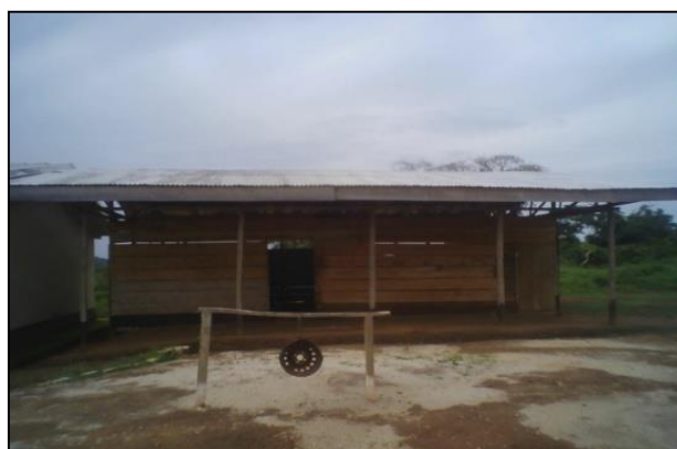
Photo 21 : Salles de classe en planche au CETIC de TONGO GANDIMA, 2017
