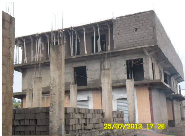
Photo7: Boutiques en construction au marché de Bantaï Cliché : CANALDEV
