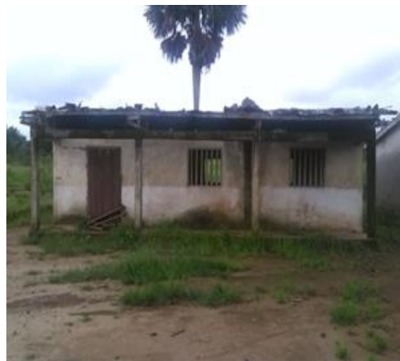
Photo 11: Vue partielle d'une salle de classe à l'école publique de Mbélébina
