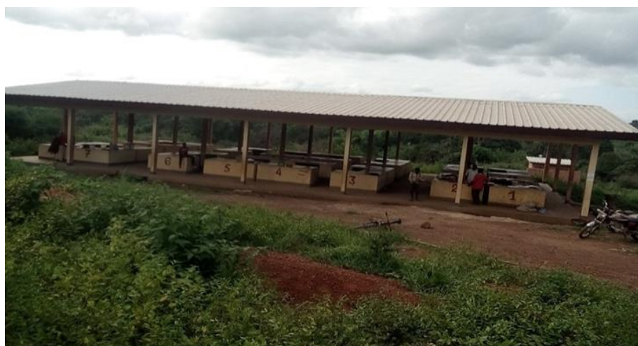
Photo 12: Vue partielle du hangar de marché de Ouli
