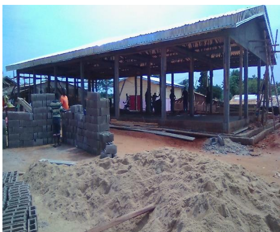
Photo 21 : Une vue panoramique de la construction du hangar de marché de Libongo
