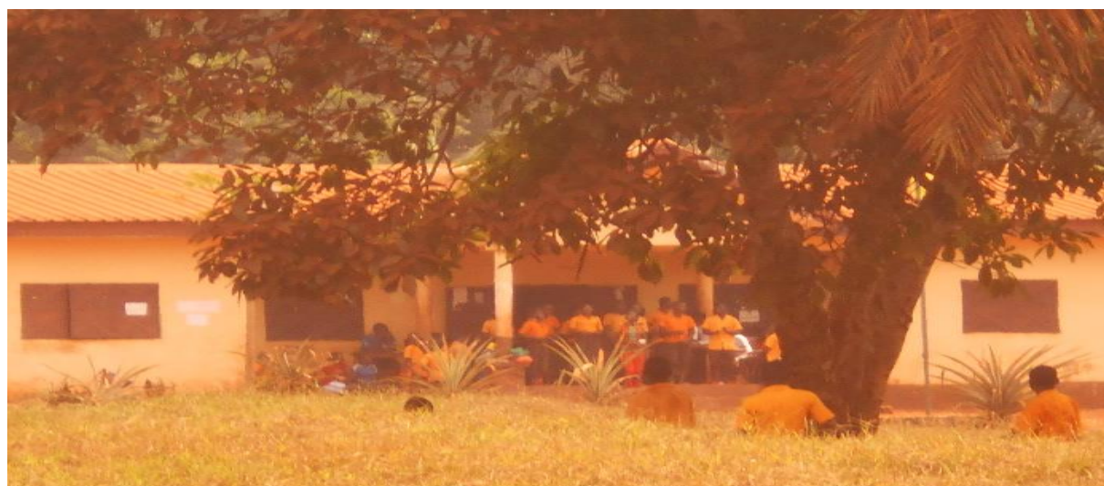
Photo 13: Vue du bloc administratif du CETIC de Salapoumbé
