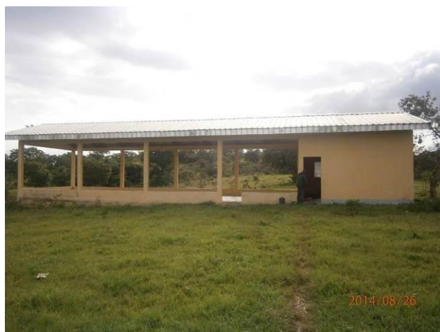
Photo 40. Marché à bétail de Tignère (Hangar) Cliché Batchanou
