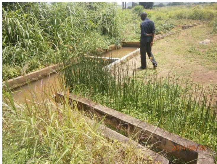
Photo 39: Dispositif de collecte, de filtrage et de distribution d'eau (Bac d'attention). Cliché Batchanou
