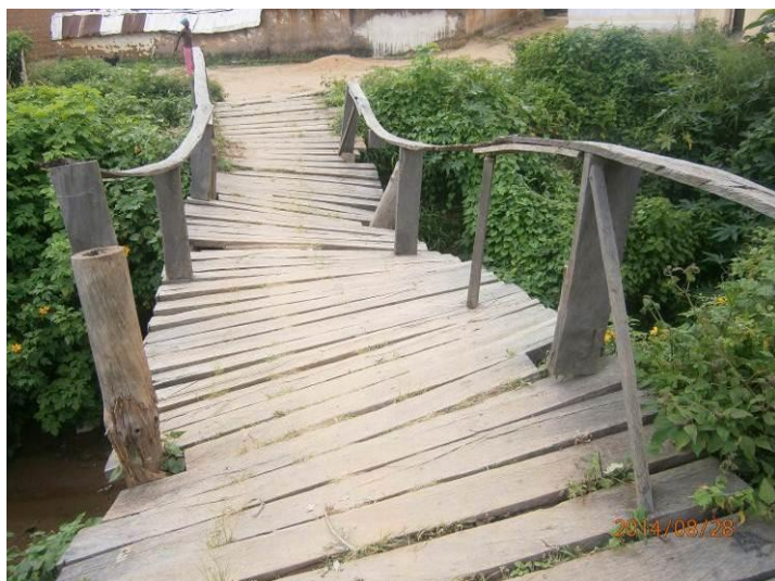
Photo 30. Pont provisoire (quartier Marouaré). (x : 12,644635 et y : 7,35778498 Cliché Batchanou
