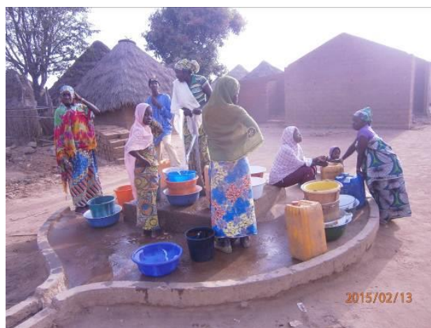
Photo 24. Forage à motricité humaine Ngaoutéré (x : 12,84674 et y : 7,55418). Cliché Batchanou
