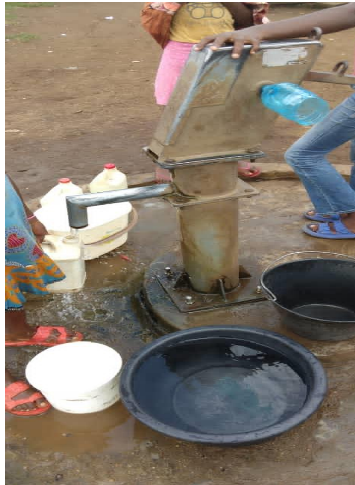
Photo3.1: Aperçu d'un forage avec PMH dans la commune de Nkongsamba 1 ier
