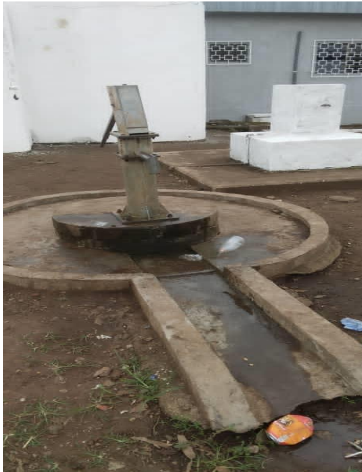
Photo3. 1:Forage équipé d'une PHM dans la commune de Nkongsamba 2
