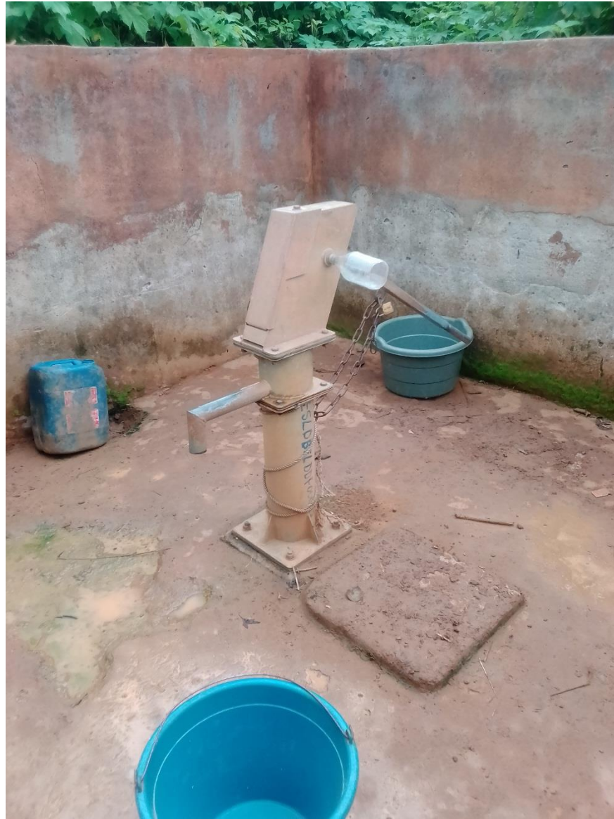
Photo 3. 3: Puits avec pompe à motricité humaine
