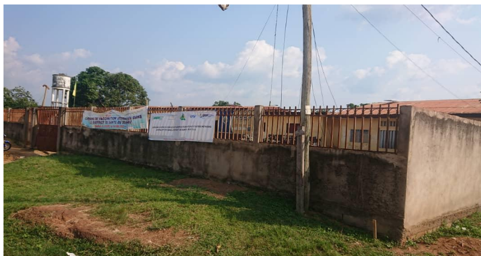
Photo 3. 6: Hôpital de District de la Commune de Belabo
