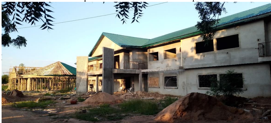
Photo 3. 4: Hôtel de ville de Gaschiga en chantier
