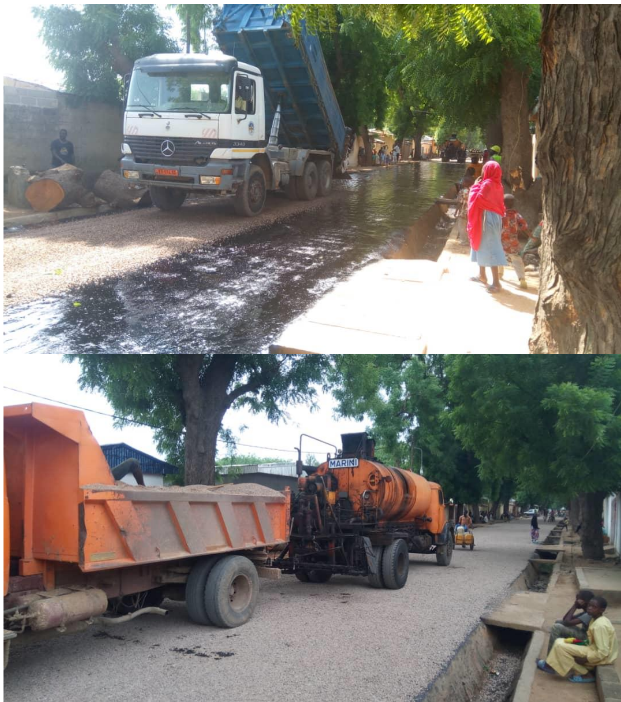
Photo 1 : Travaux d'aménagement de la voirie dans la commune de Maroua 1 er (GP 2017)
