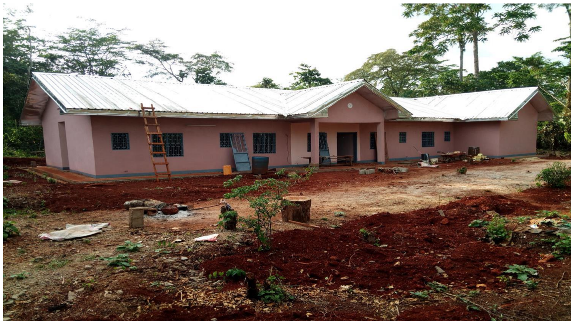
Photo 2 : Travaux de construction d'un campement municipal dans la commune de Mambele (GP 2017)
