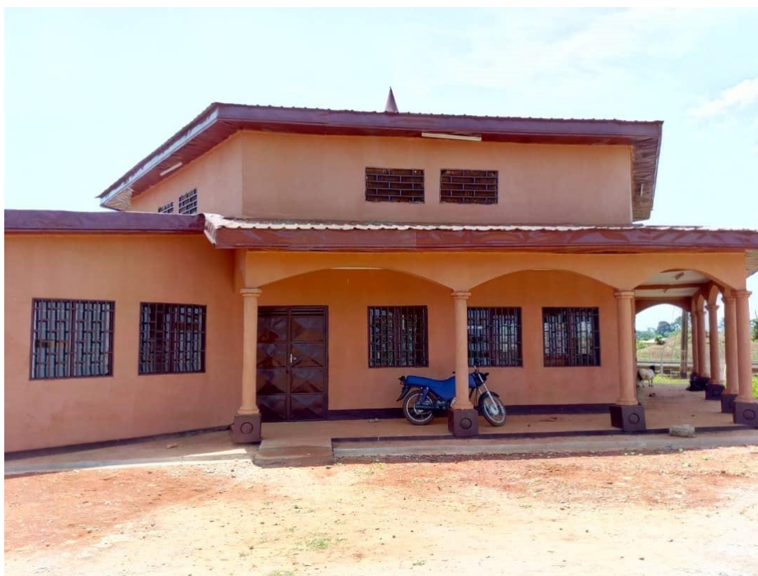
Photo 3 : Construction d'une salle polyvalente multifonctionnelle dans la commune de Kentzou (GP 2017)
