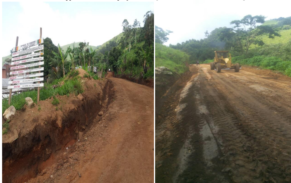
Photo 1 : Travaux en rapport avec le microprojet financé par le GP 2017 dans la ville de Njikwa
