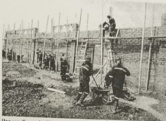
Une vue d'un projet Himo en réalisation.
