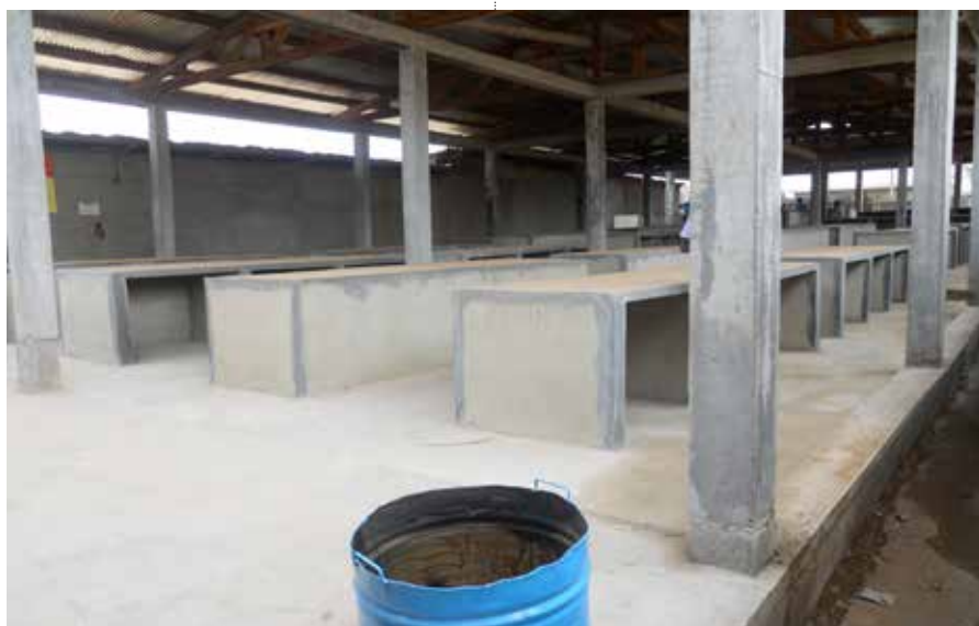
Le marché central de Ntui en construction
