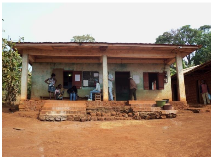
Photo 11 : Bâtiment d'accueil et de consultation d'une formation sanitaire de Mbouda
