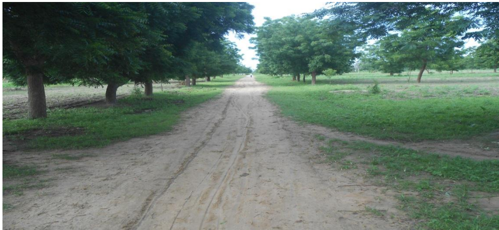
Photo 4: Une vue panoramique d'une route communale
